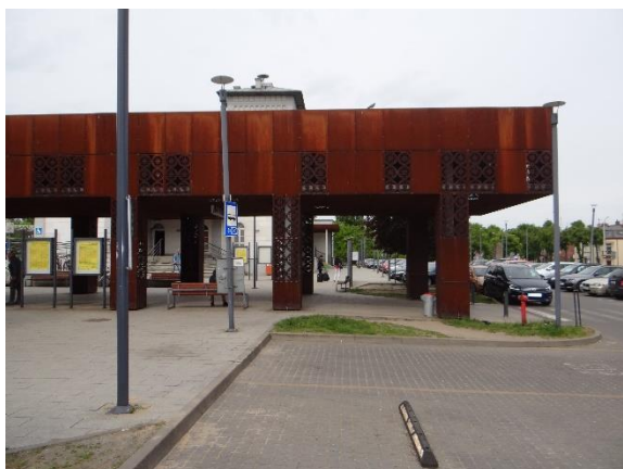
Fot. 3. Pętla autobusowa przy ul. 3 Maja
