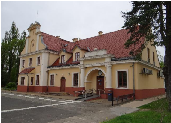
Fot. 2. Budynek dworca i plac dworcowy
