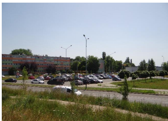
Fot. 5. Przystanek na wiadukcie przy ul. Aleksandrowskiej
