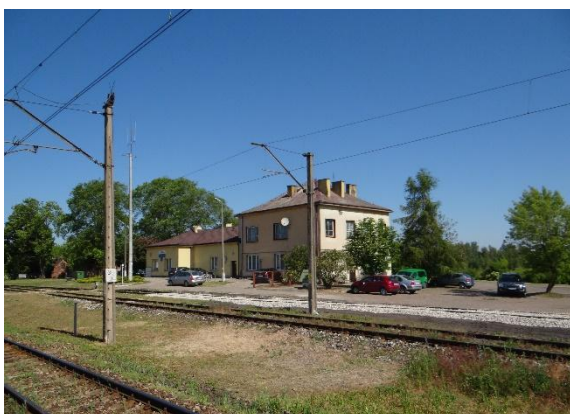
Fot. 5. Droga doprowadzająca do węzła
