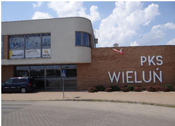
Fot. 5. Stanowiska na dworcu autobusowym
