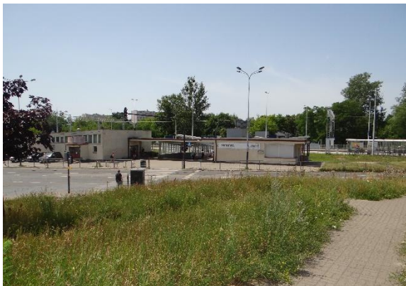
Fot. 2. Wejście na peronu od strony ul. Plantowej
