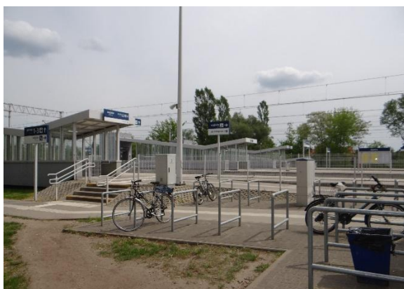
Fot. 5. Droga dojazdowa od strony wschodniej, ul Twarda
