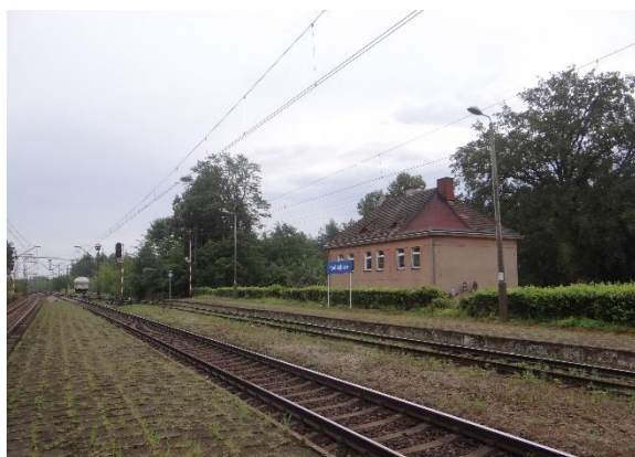
Fot. 5. Droga doprowadzająca do węzła
