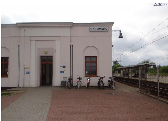
Fot. 5. Parking samochodowy
