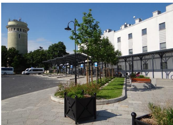
Fot. 5. Parking samochodowy
