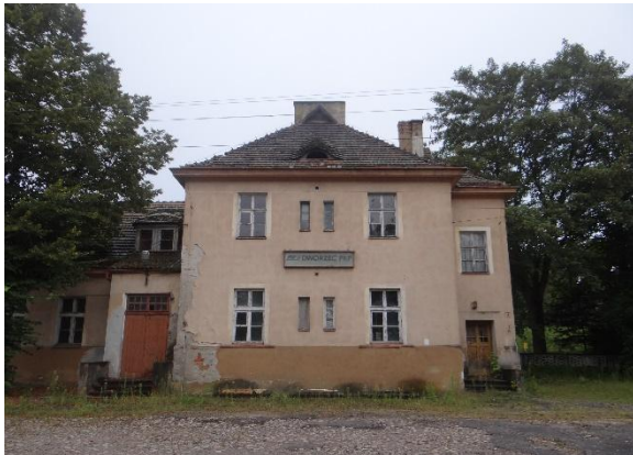
Fot. 2. Budynek dworca widok od strony stacji
