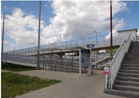
Fot. 5. Przystanek autobusowy przy ul. Maratońskiej
