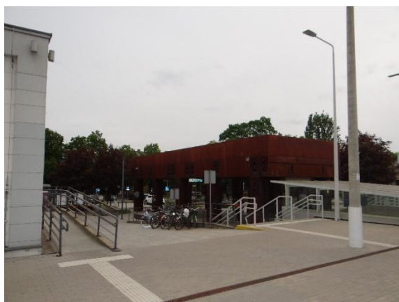
Fisza diagnostyczna 4. Węzeł Łask (źródło: BPPWŁ w Łodzi)
