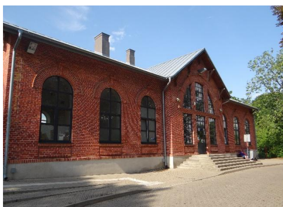
Fot. 1. Budynek dworca
